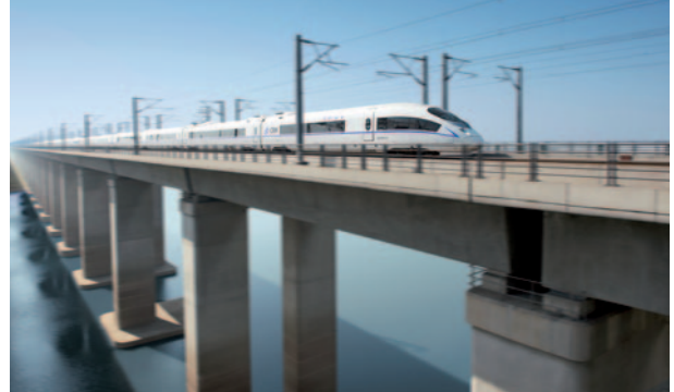
BETONJAVÍTÁS ÉS SZERKEZETMEGERŐSÍTÉS
