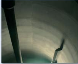
Szemcseszórás a 75 µm-es felületprofil kialakításához SA 3 szerint szemcsés anyaggal
